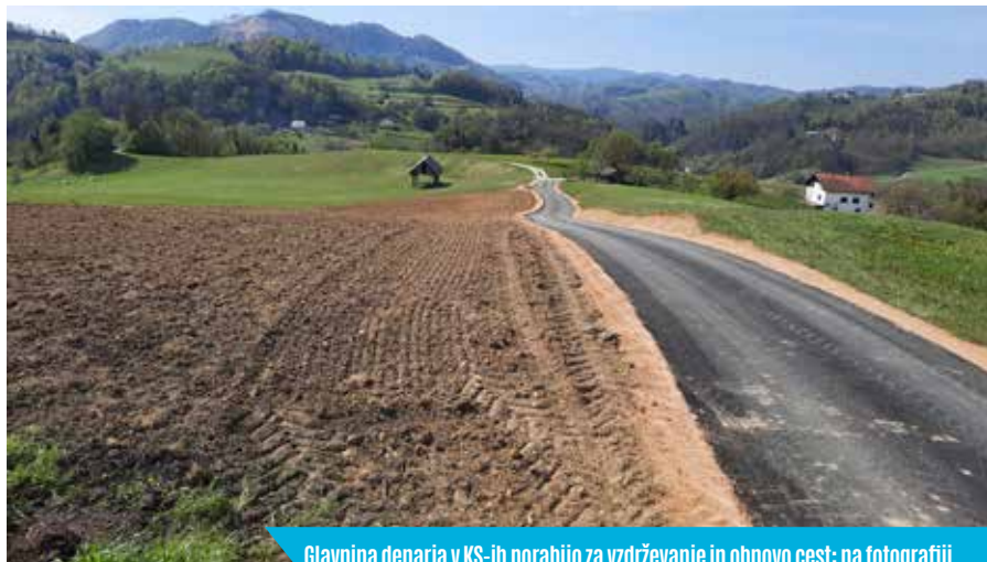
Glavnina denarja v KS-ih porabijo za vzdrževanje in obnovo cest; na fotografiji obnovljen odsek Artiček-Pevce v Grobelcah. Foto: arhiv občine
